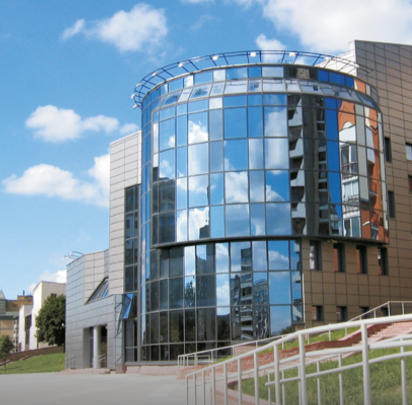
Реконструкция торгового объекта с пристройкой административных помещений в Минске. Архит.: А. Корбут, А. Белоусов
